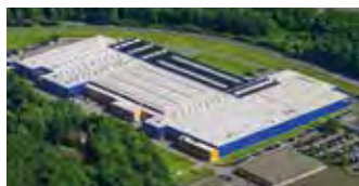
Hörmann KG Eckelhausen, Allemagne
